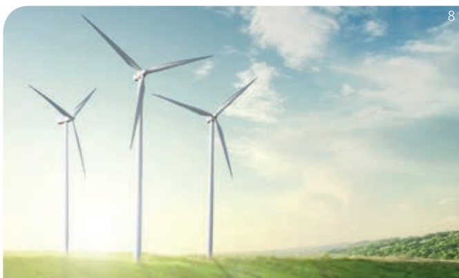
Windkraftanlagen – Beispiel für Bauteil aus GFK: Rotorblätter
