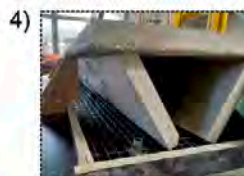
Abb. 2: Herstellung der Deckenelemente mit Falten durch thermoplastisches Umformen der zunächst noch offenen Carbonbewehrung-Zwischenstege
