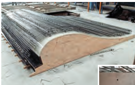
Herstellung der Carbon-Bewehrungskörbe anhand der Surfwellenform
