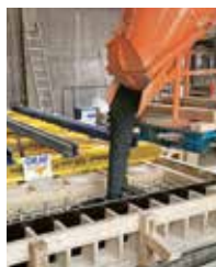
Betonage mit SVB
