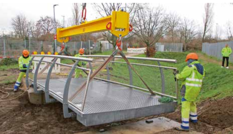
Montage der Brücke in Wesseling
