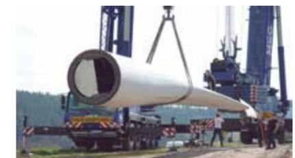
Abb. 1: Rotorblatt beim Rückbau einer Windkraftanlage
