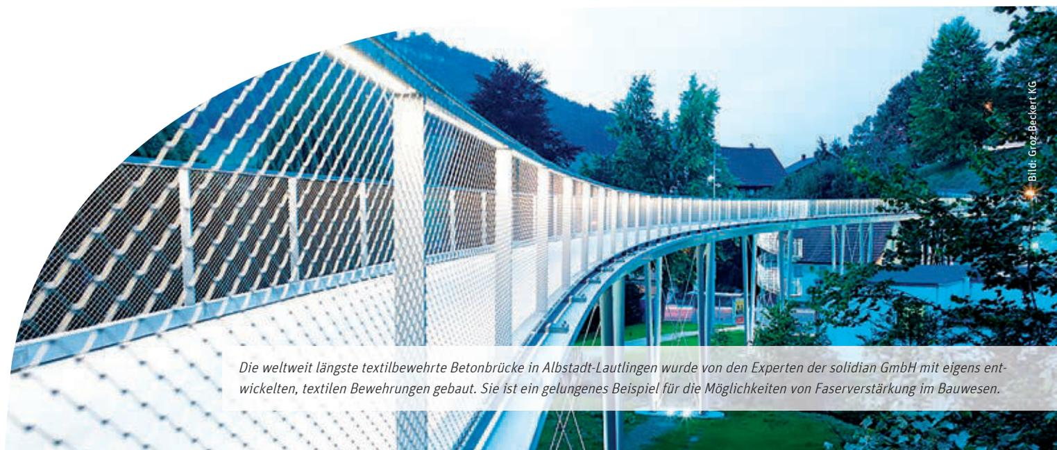
Die weltweit längste textildbewehrte Betonbrücke in Albstadt-Lautlingen wurde von den Experten der solidian GmbH mit eigens entwickelten, textilen Bewehrungen gebaut. Sie ist ein gelungenes Beispiel für die Möglichkeiten von Faserverstärkung im Bauwesen.
